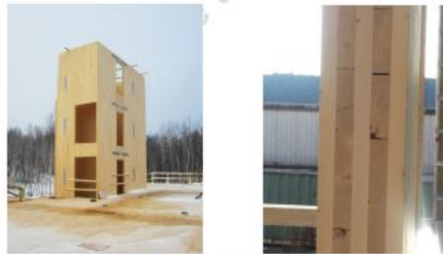
Figure 2 : Exemple d'une cage d'escalier en CLT
