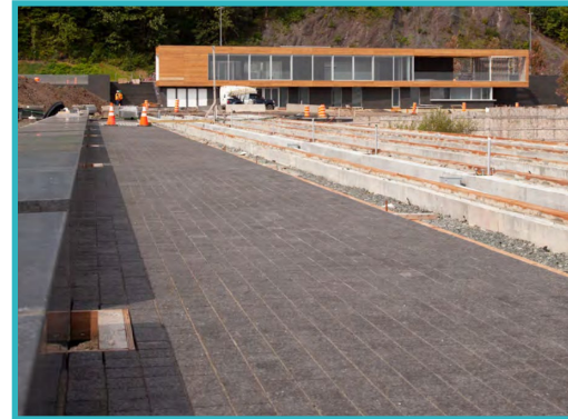
Infrastructures – Phase 3 de la Promenade Samuel-de-Champlain à Québec
