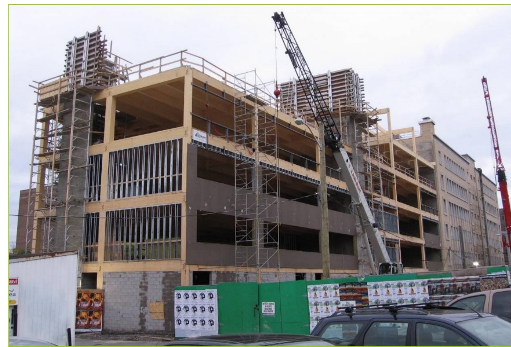
Cages d'escalier et murs en béton
